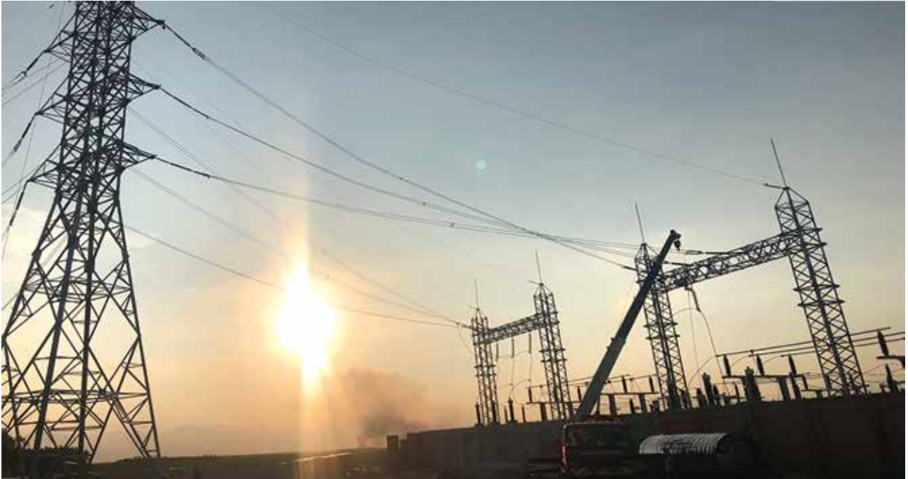
Đấu nối đường dây 110kV vào Trạm biến áp Nhà máy Điện mặt trời Sơn Mỹ 3.1
