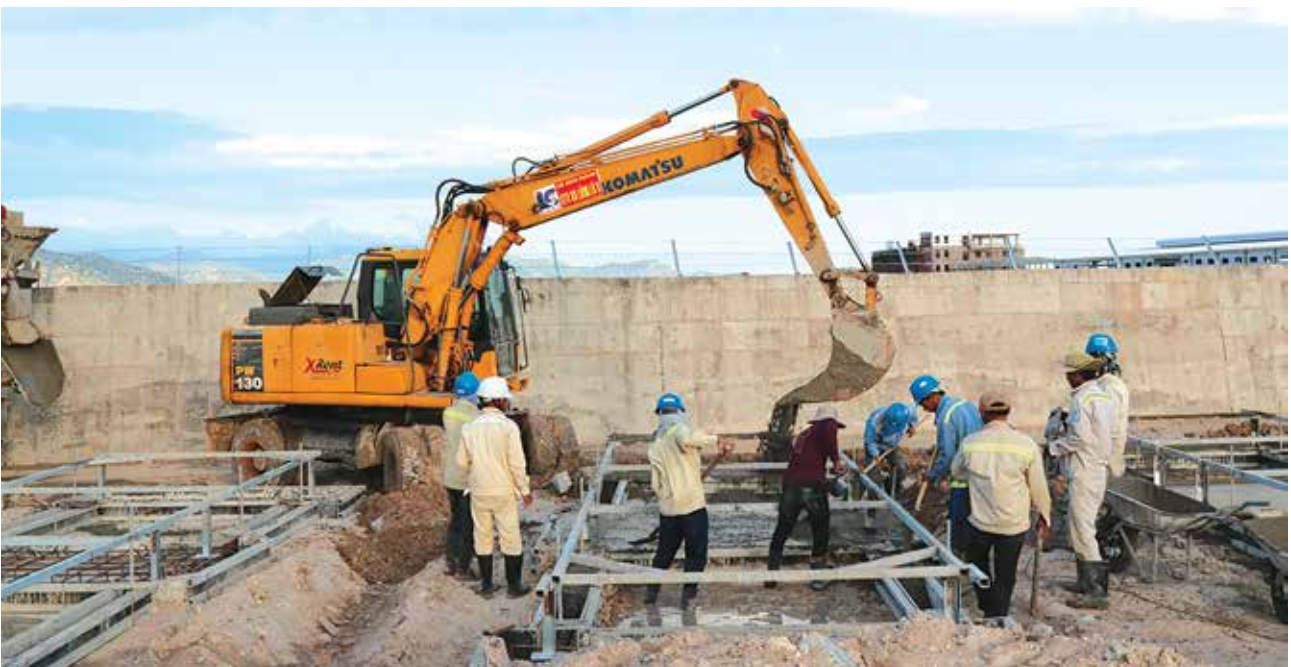
Thi công xây dựng hố móng Nhà máy Điện mặt trời tại TTDL Vĩnh Tân
