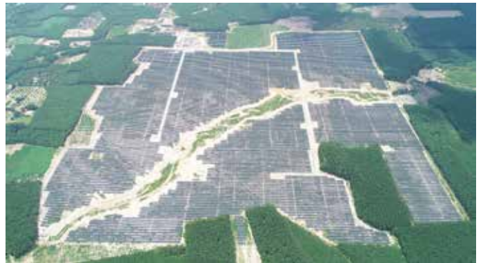
Nhà máy Điện mặt trời Sơn Mỹ 3.1
